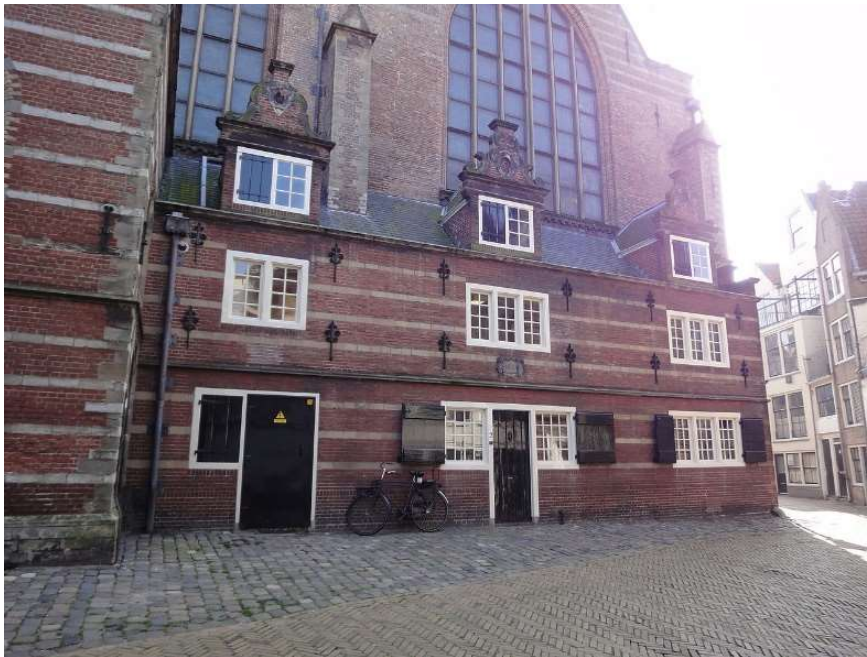
Het zakkendragersgilde in Gouda had een eigen kantoortje, in een van de muurhuisjes aan de Sint Jans Kathedraal (foto: internet).
